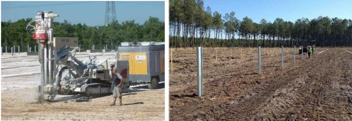
Figure 18 : Ancrage au sol par pieux battus (Source : Solvéo)
